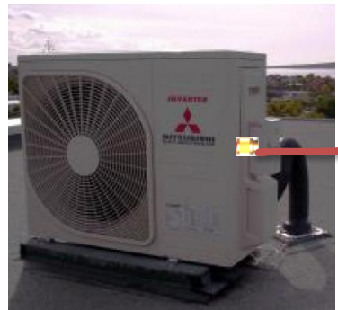
Кондиционер / Холодильная система
