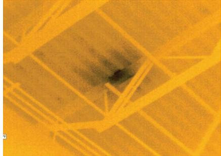
**Рис. 5-21.** Тепловизоры можно использовать для обнаружения влажной теплоизоляции, связанной с течью в кровле с небольшим уклоном. Если условия подходящие, а металлический настил крыши окрашен, то такие следы можно увидеть изнутри.
