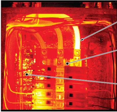
ПРОВОДНИК С ИЗОЛЯЦИЕЙ ИМЕЕТ ВЫСОКИЙ КОЭФФИЦИЕНТ ИЗЛУЧЕНИЯ (ИСПУСКАЕМОЕ ТЕПЛОВОЕ ИЗЛУЧЕНИЕ)
