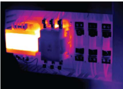
**Рис. 5-18.** Возможный дисбаланс нагрузки на правом дальнем предохранителе можно не увидеть, если не отрегулировать уровень и диапазон изображения.
