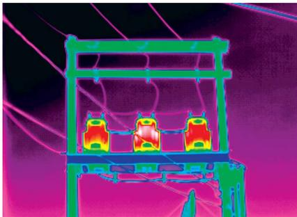
**Рис. 5-40.** Трансформатор, который теплее других на воздушном блоке, может указывать на возможную проблему.
