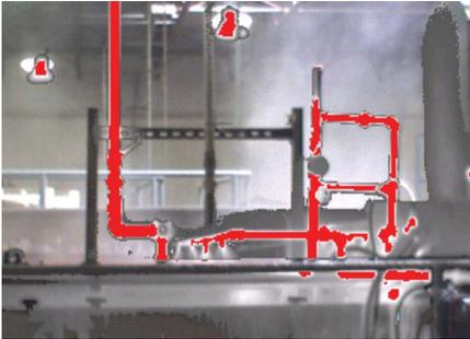
**Рис. 5-22.** Использование цветов насыщения и цветовой сигнализации серой палитры может быть полезным для определения того, какие вентили горячей воды и пара открыты и работают правильно.
