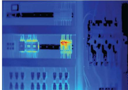
**Рис. 5-17.** С помощью тепловизора проблему внутренних элементов пульты управления двигателями легко выявить.
