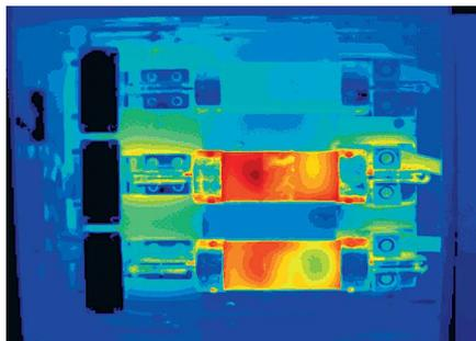
**Рис. 5-1.** «Горячее пятно» на тепловом изображении не всегда указывает на основную проблему. Может быть вышедшим из строя верхний предохранитель, а так же могут быть проблемы с центральным предохранителем.
