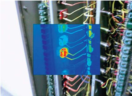
**Рис. 5-82.** Область ярких цветов указывает на возможное соединение с высоким сопротивлением или отказ компонентов в шкафу управления освещением.
