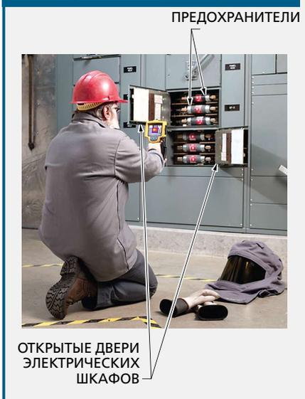
**Рис. 3-3.** Если электрические шкафы должны быть открыты, необходимо тщательно разработать и соблюдать методики, которые уменьшат риск электрического пробоя.
