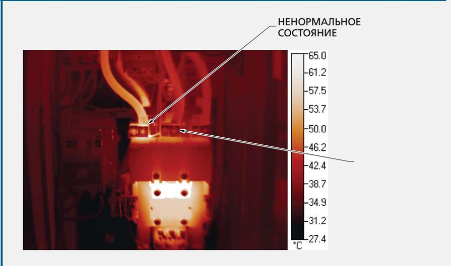
**Рис. 2-1.** Тепловые сигнатуры работающего оборудования могут быстро указать на нормальное и ненормальное состояние.
